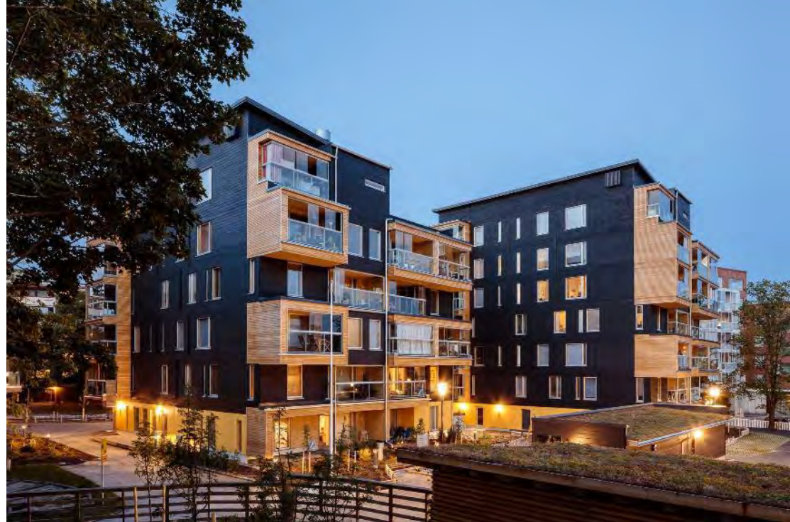
Kuvan lähde: Puuinfo, Eskolantie
