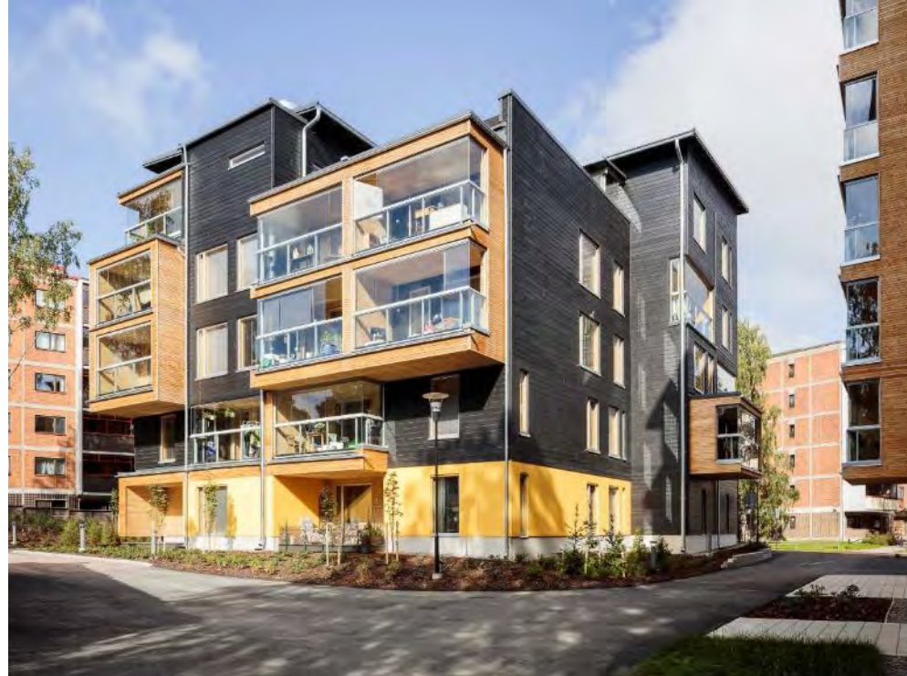
Kuvan lähde: Puuinfo, Eskolantie
